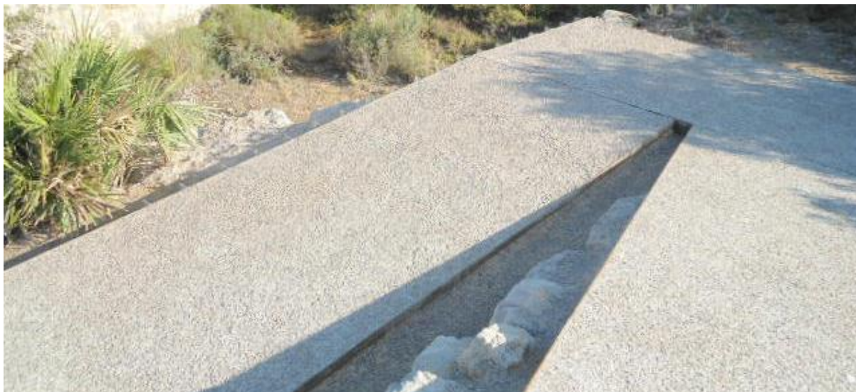
Aspecte del formigó amb acabat rentat a l'àcid, i ampliació de la textura que presenta.
